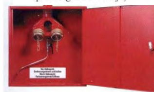
Slika 146: Zidni hidrant G52 (s plosko gasilsko cevjo)
